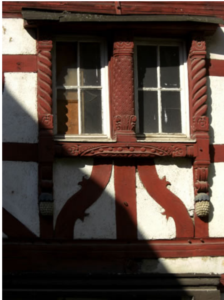
Schmuckbalken an der Unteren Mühle in Fahr
