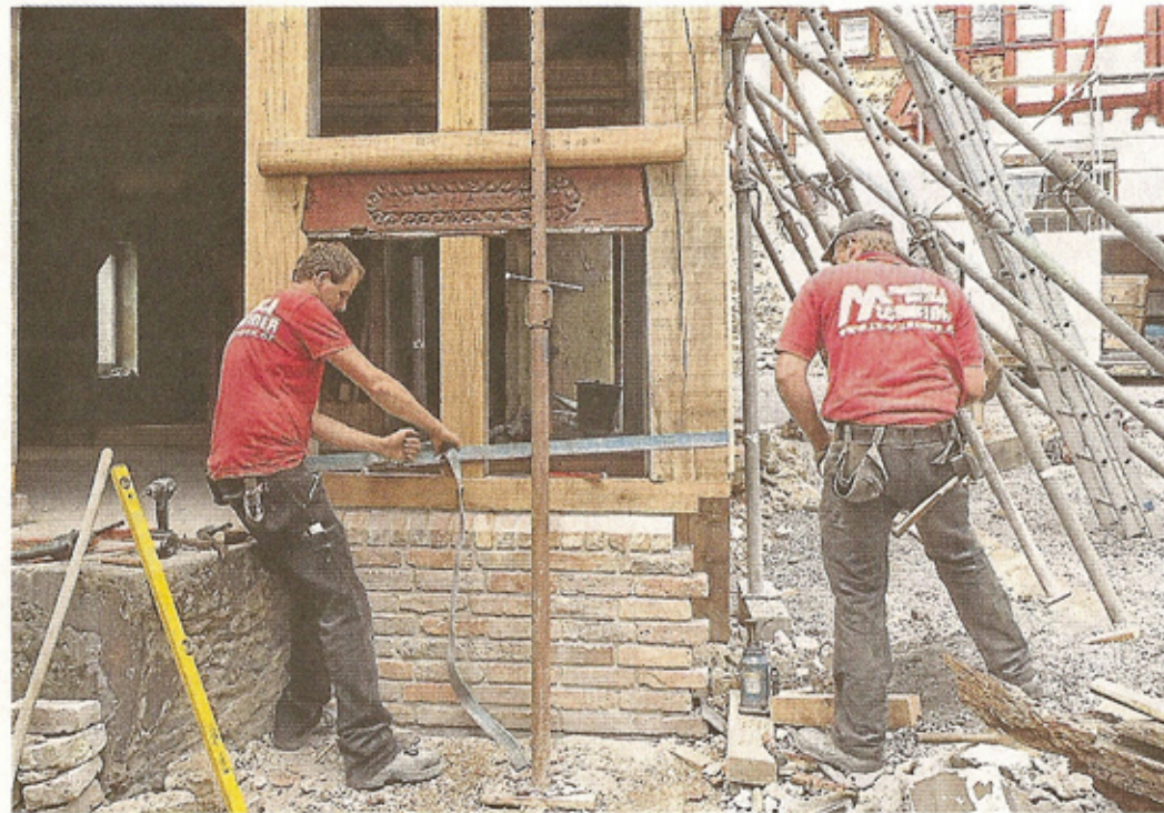
Bild links: Für verschiedene Arbeiten wie das Ersetzen der maroden Balken muss der Bürgerverein Fahr auf erfahrene Fachmänner zurückgreifen. Bild rechts: So wie auf diesem Modell soll das Backesmännchenhaus in Fahr nach Abschluss aller Sanierungsarbeiten einmal aussehen. Der Leutesdorfer Manfred Mertesacker schuf die verkleinerte Ansicht.
